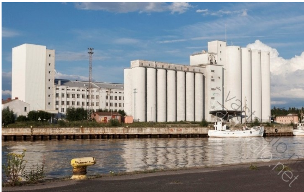
Рис. 7. Элеватор до реконструкции, г. Оулу, Финляндия.
