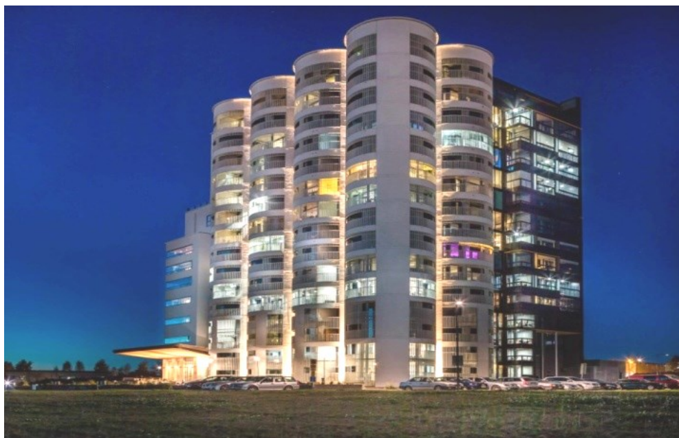
Рис. 8. Элеватор после реконструкции мастерской PAVE Architects.
